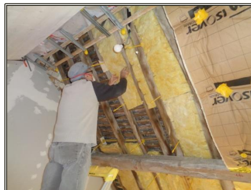
Insertion d'une première couche d'isolant
