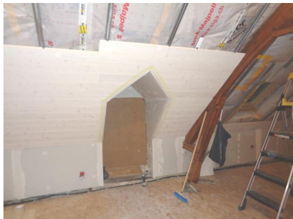
Pose des lambris à l'aide de clips vissés sur les rails
