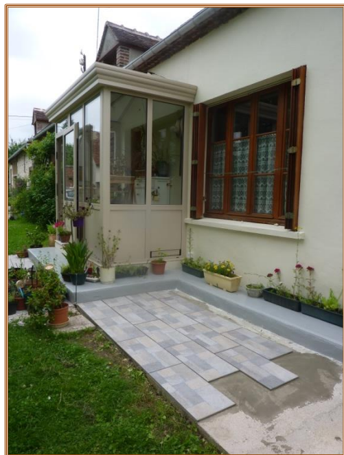
Pose carrelage avec jointoyage
