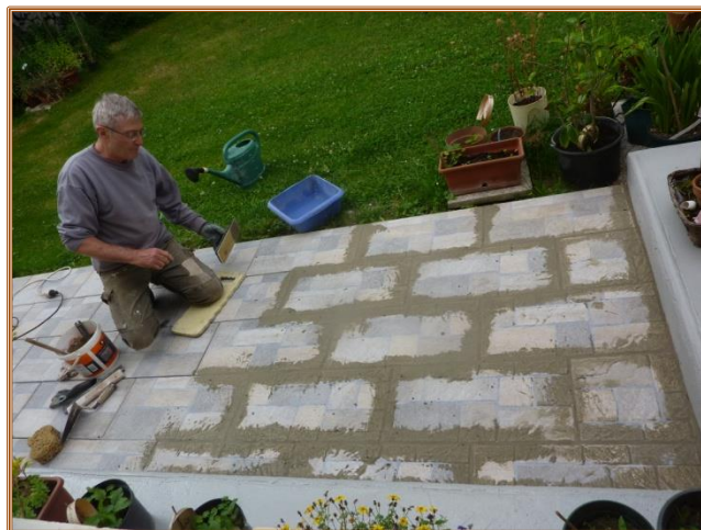
Pose carrelage avec jointoyage
