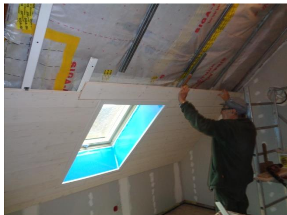
Montage, installation et encadrement du vélux
