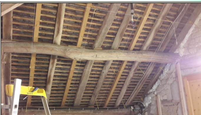
Pose des suspentes
