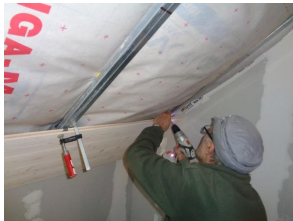
Pose des lambris à l'aide de clips vissés sur les rails
