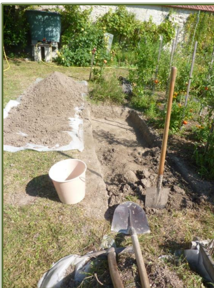
Opération décaissage sur 50 cm de profondeur
