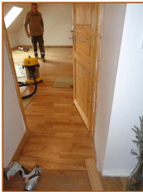
Pose du parquet clipsable
