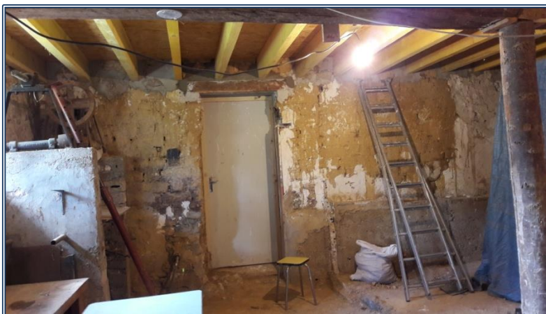
Encastrement et scellement des solives et pose du plancher par un artisan
