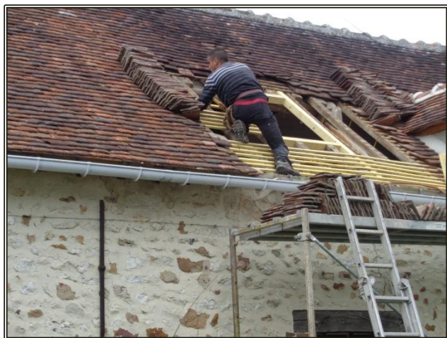
Pose du vélux et réfection toiture
