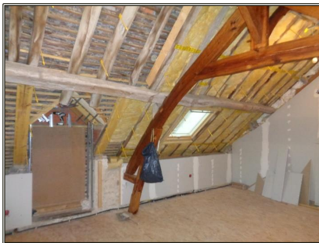
Insertion d'une première couche d'isolant
