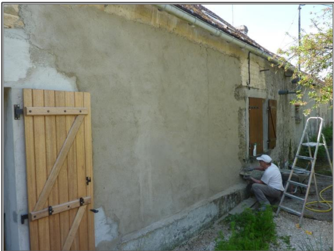
Crépi côté nord
