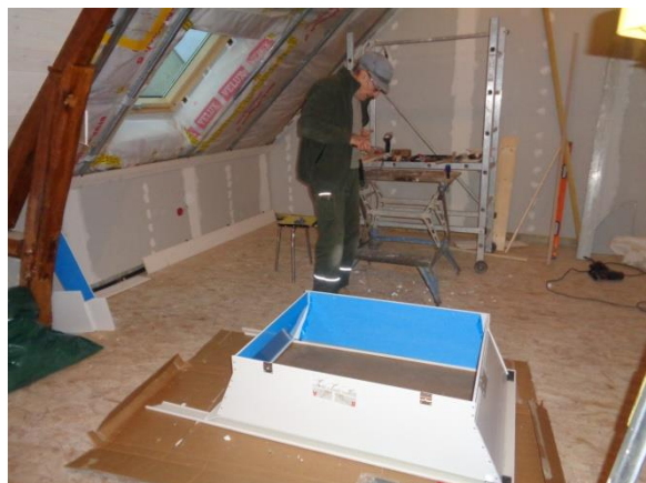
Montage, installation et encadrement du vélux
